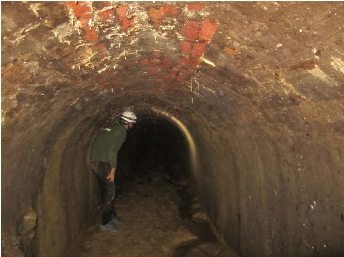
Figura 20. Segundo codo en el lateral 1 y tramo con revestimiento de ladrillos cementados y espeleotemas de calcita.
