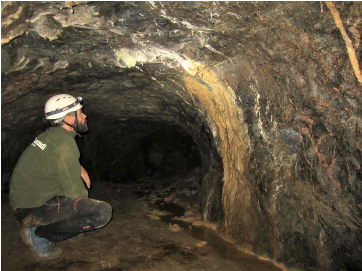
Figura 19. Parte central del lateral 1, por donde ingresa un pequeño hilo de agua, con pequeñas espeleotemas de calcita y vetas de cuarzo en la roca-caja.
