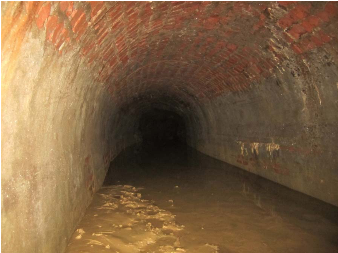
Figura 21. Espeleotemas isotubulares de calcita en el tramo cementado y continuación inundada de la galería.
