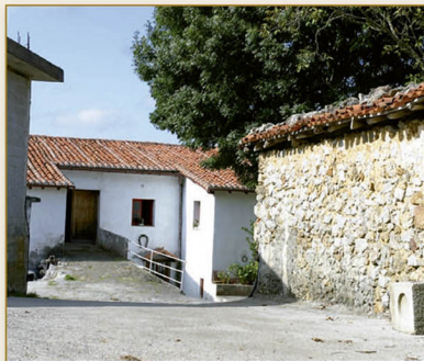
Detalle de las entradas actuales en su fachada lateral derecha. Año 2008.
