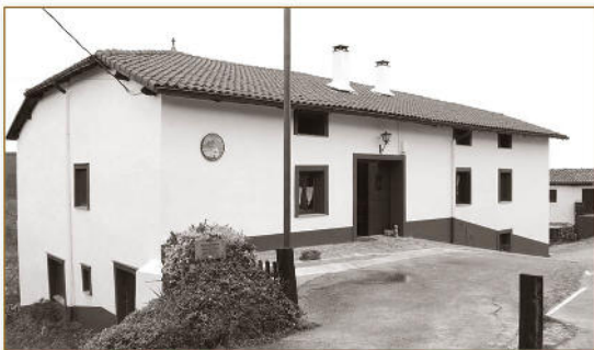
Arriola Txiki. Vista de su fachada lateral derecha y trasera. Año 2016.
