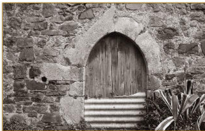
Arriola Beña. Detalle de arco ligeramente apuntado, con la particularidad de no tener clave y unirse con dovelas. Año 2016.
