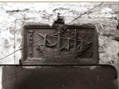
Pieza de piedra arenisca con motivos heráldicos encima del dintel de la desaparecida casa torre de Urсандía, en la margen izquierda de la ría días después de fuera asolada por un voraz incendio. Diciembre de 1989.
