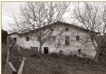
Arriola Goieta. Vista de su fachada principal. Año 2016
