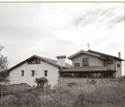
Arriola Perla. Vista de las fachadas traseras del conjunto. Año 2016.
