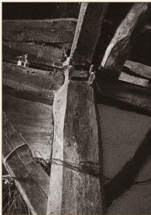
Detalle de uno de los cuatro pies derechos que sostienen la estructura de madera de la casería Arroan Haundi. Setiembre de 2016.
