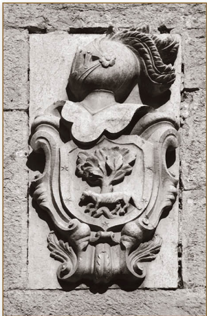
Piedra armera existente en la fachada principal a nivel de su planta principal. Setiembre de 2016.
