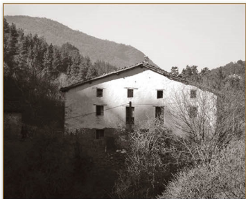
Vista general de la fachada principal de Arroan Zaharra, antes de su derribo. Febrero de 2008.
