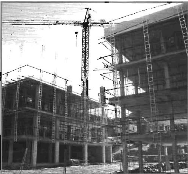
Situación actual de las obras de las viviendas de Visesa.
