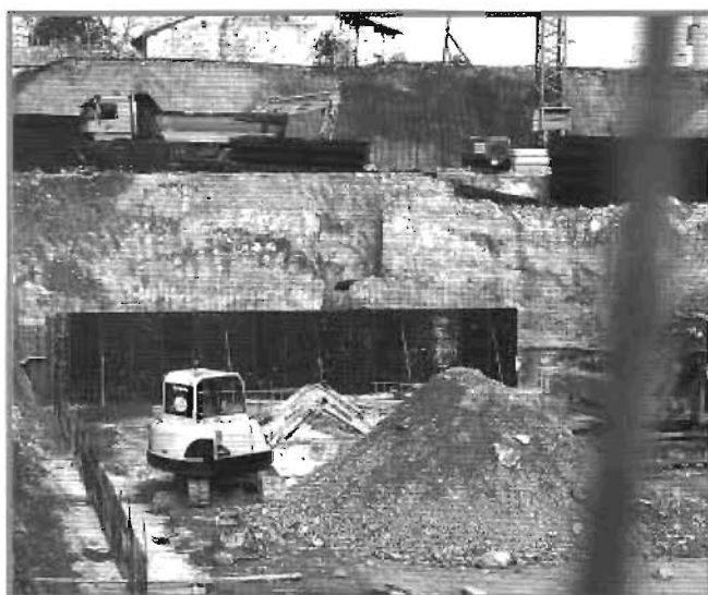
Máquinas trabajando en la zona.
