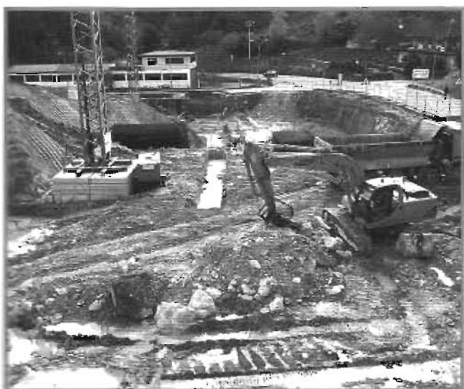
Vista general de las obras.
