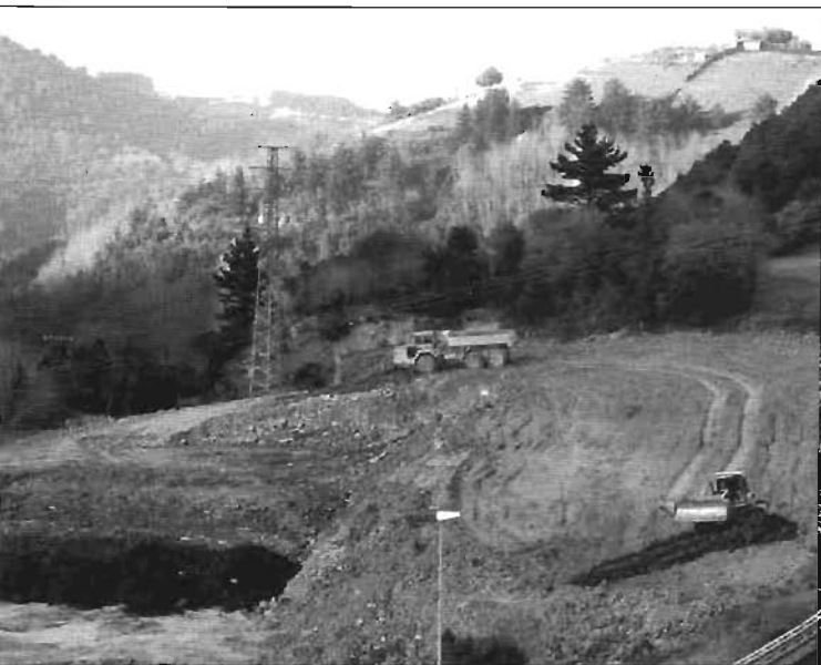
Obras de restauración en la zona de Mallubate.
