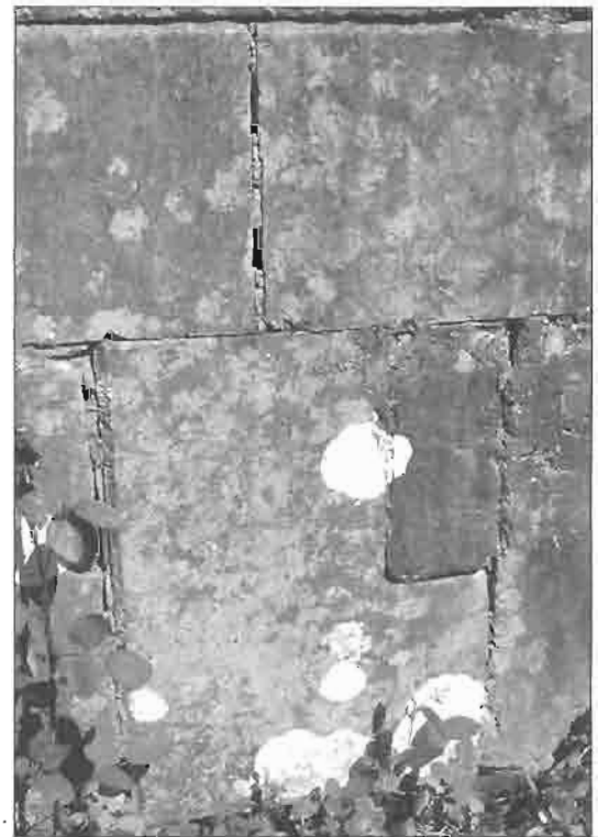
Detalle del frontis con losa trabajada
