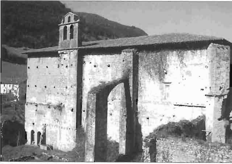
Fachada sur de la iglesia.
