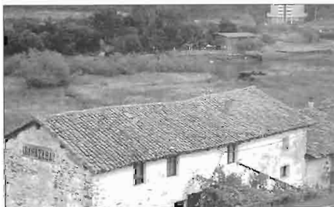
Desde el caserío Irarrazabal se aprecia la rotura del dique
