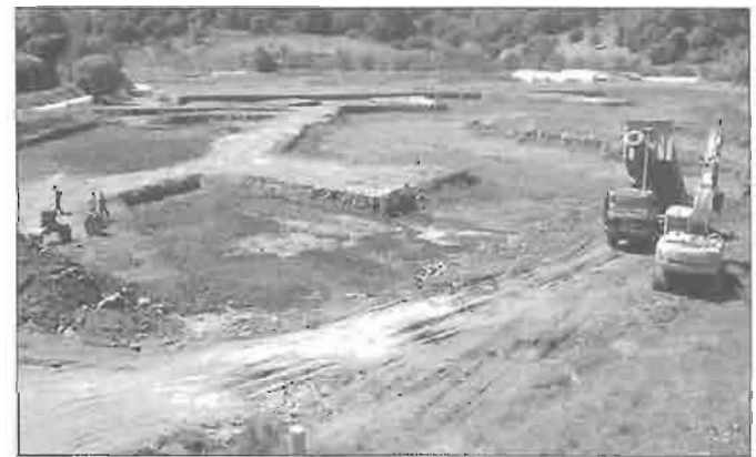
Trabajos de restauración en agosto de 2007.
