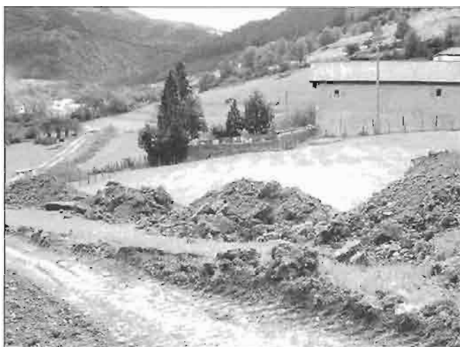
Vista general de las obras (17-08-2006)
