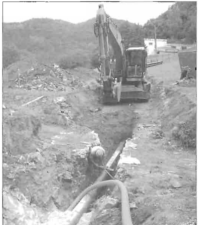
Colcacion de la tuberia en la zanja (25-08-2006).
