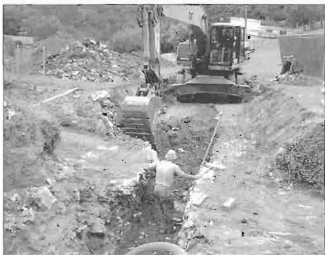
Vista general del corte efectuado sobre la calzada (25-08-2006)
