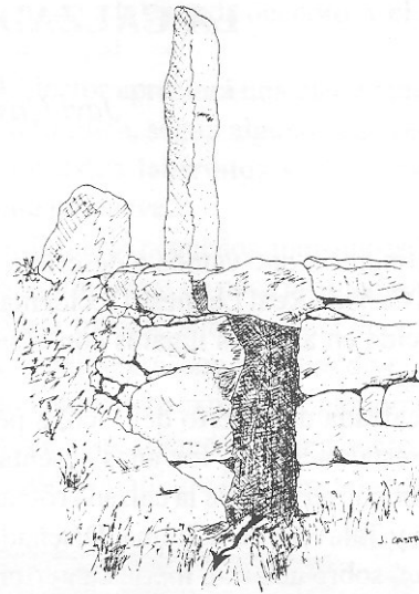
Salida de desagüe subterráneo y mojón
