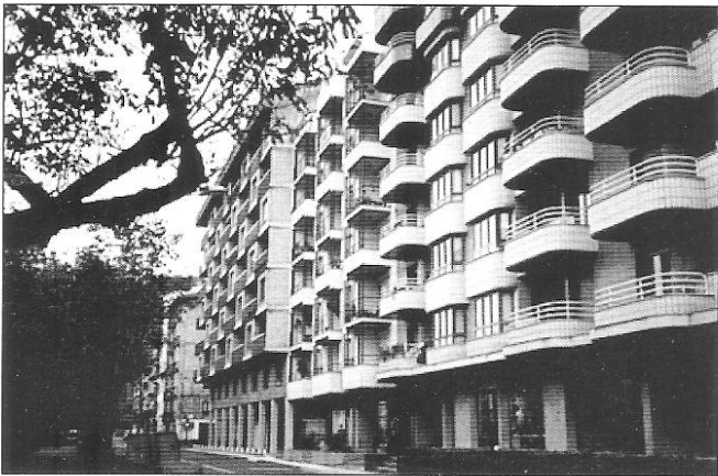
Calle Arenal, 1.994. En el centro, el edificio Naranjaikoa (Arenal, 7)
