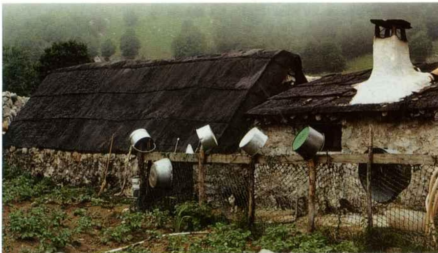
Txabola de José M. Oiarbide en la campa de Oltza en el macizo de Aitzgorri (Gipuzkoa). Obsérvese la techumbre chapa de bidón embreada y las marmitas empleadas en el ordeño. (Cliché: Fermín de Leizaola, 140791.)
