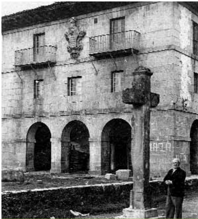
Udaletxea eta gurutzeta / Ayuntamiento y crucero
