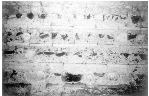
Fig. 14. Mur construit avec des amphores à Aubié au Mas-d'Agenais (cliché C. Piot).
