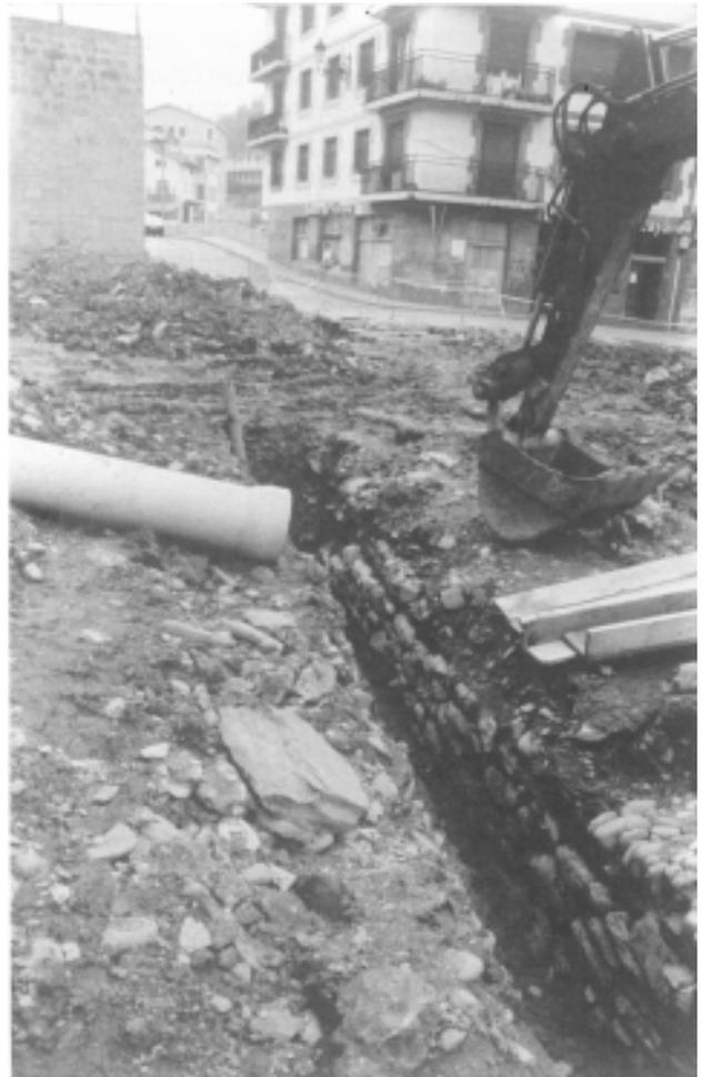
Foto 6. Descubrimiento de la cimentación de la torre medieval de Olaso-Garbova, durante las obras de reurbanización de la plaza. (Elgoibar).
