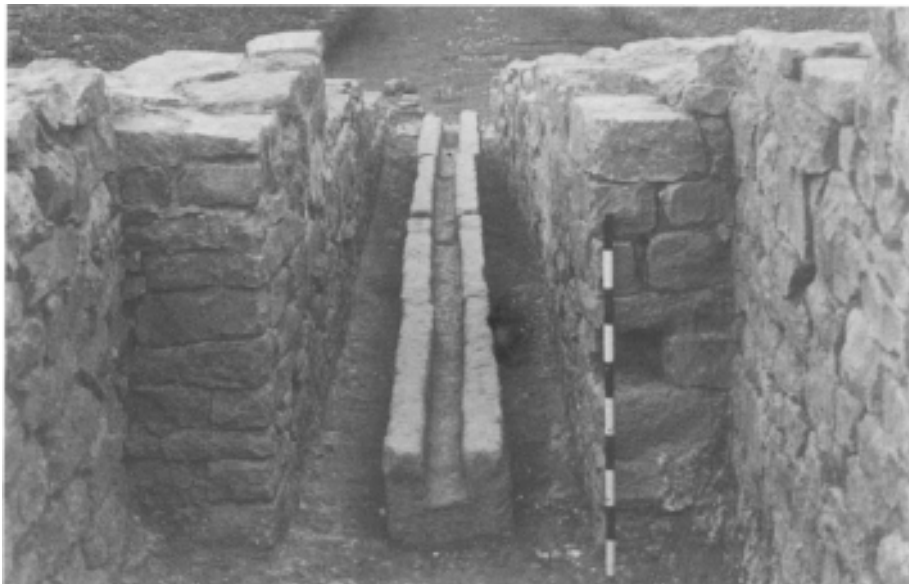
Foto 2.— Andelos. Depósito regulador. Salida del acueducto.
