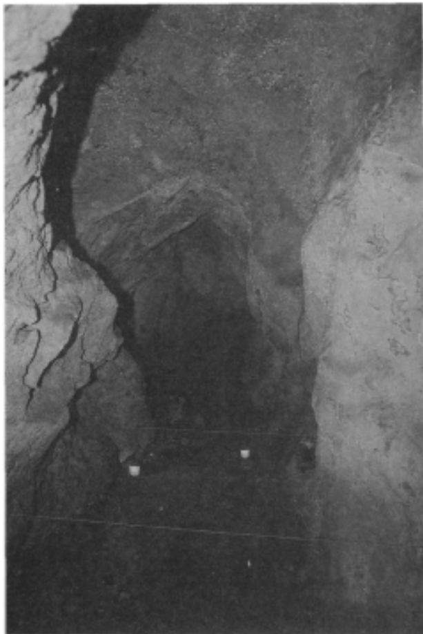
Foto 3. Galería Sur, desde el interior.
